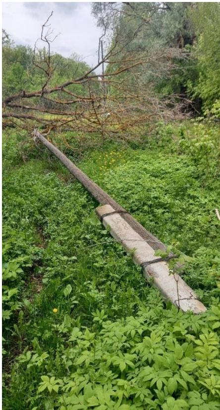
**Рис. 1 Разрушение опоры ВЛЭП упавшим деревом**
