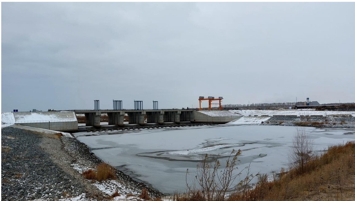
Рисунок 4 - Гидроузел (бетонная плотина) – 2022 год
