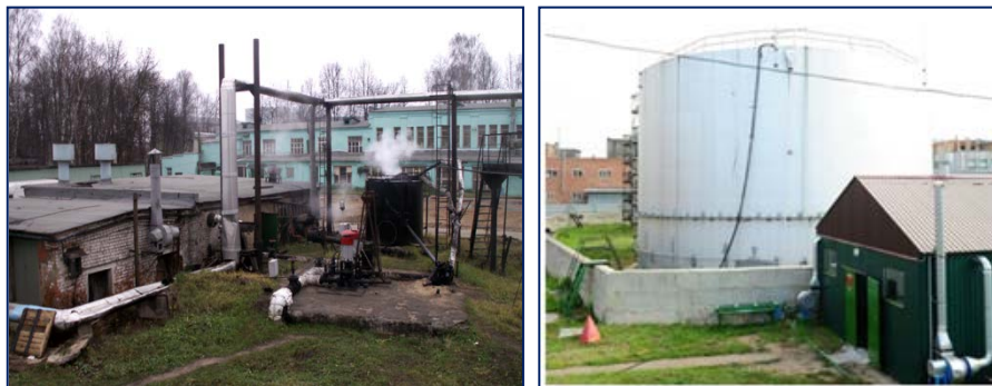
Рис. 1. Мазутная станция до и после реконструкции
