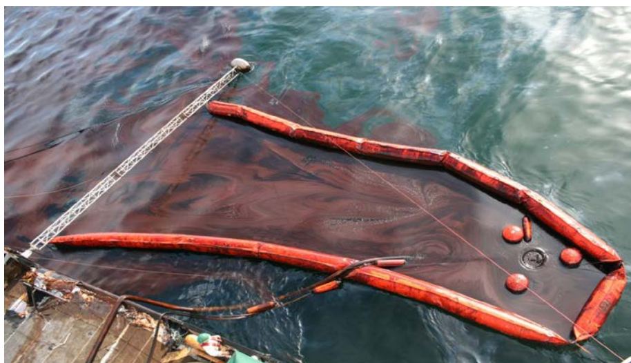
Рис. 1. Боновые заграждения при разливе нефтепродукта
