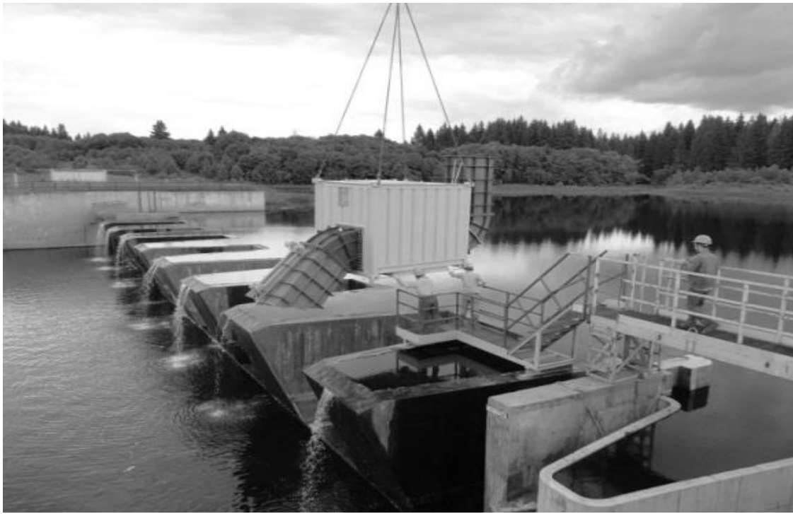
Рис. Установка энергетического блока мини ГЭС на полигональный водосброс р. Нерль
