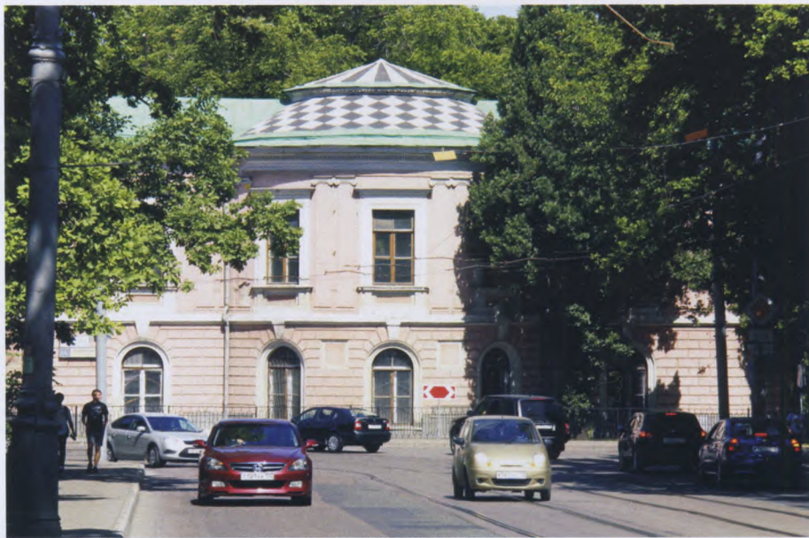
Вид здания кафедры лесоводства (учебный корпус № 13). Современный вид здания
