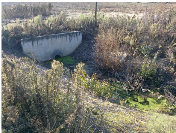
Рис. Сооружение на осушительном канале
