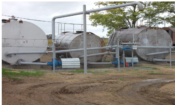
Рис. 5. Общий вид растворяющего узла для производства жидких КОУ
