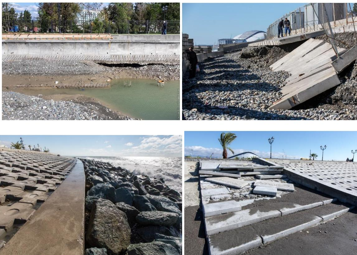
**Рисунок 1. Разрушения берегозащиты и набережной в 2013-2018 гг.**
