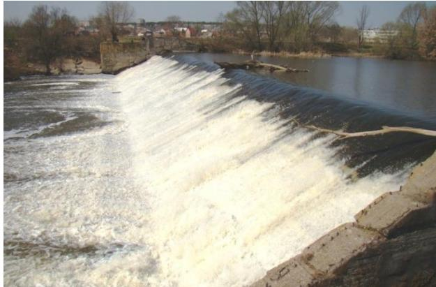
Рис. В.3.6. Прямоугольный в плане водосливной оголовок плотины на р. Наре (водослив практического профиля)
