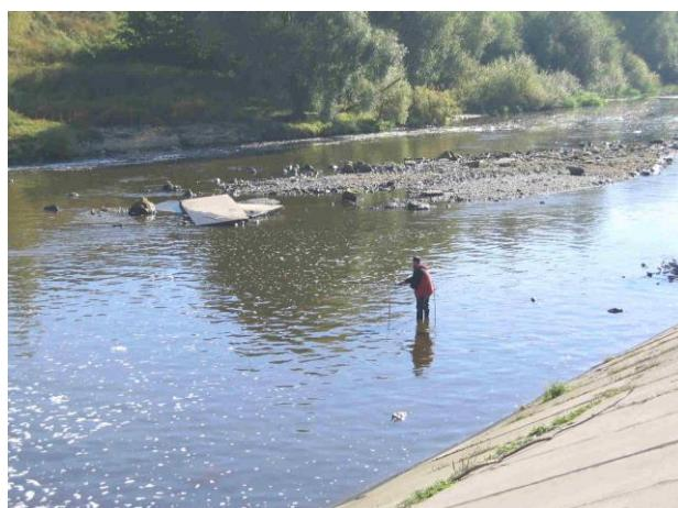
Рис. В.7.2. Продукты размыва рисбермы и отводящего русла плотины на р. Пахре
