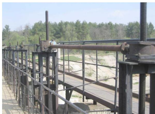
Рис. В.4.4. Ручные подъемники с синхронизирующим валом плотины на р. Клязьме
