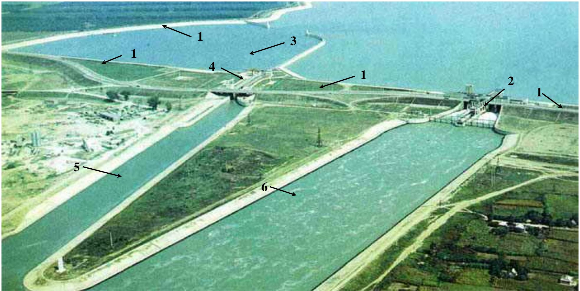
Рис. 2.2. **Общий вид Краснодарского гидроузла:** 1 – земляная плотина; 2 – водоотводная плотина (два крайних водопропускных пролета; центральный пролет – рыбоподъемник); 3 – аванпорт; 4 – судоходный шлюз; 5 – низовой подходной канал судоходного шлюза; 6 – отводящее русло водоотводной плотины
