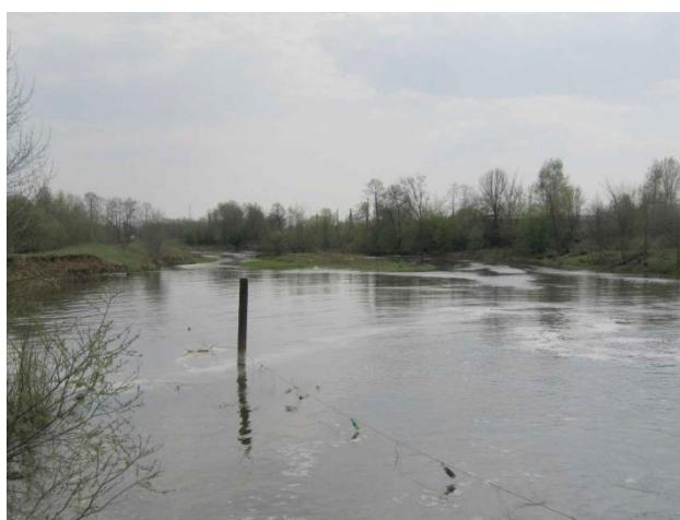
Рис. В.7.3. Отводящее русло плотины на р. Шерне (размыв левобережной дамбы и формирование острова из продуктов размыва)
