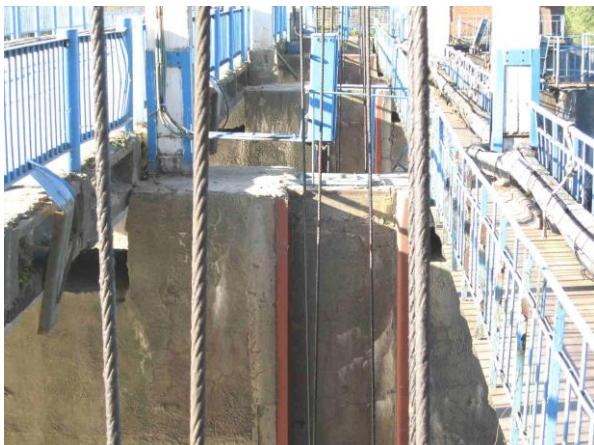
Рис. В. 4.11. Пазы для основных затворов плотины Новленского водохранилища на р. Пахре
