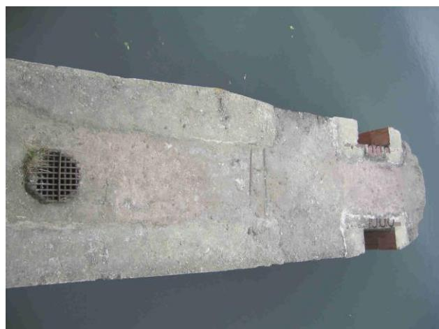
Рис. В.4.9. Пазы для ремонтных затворов плотины на р. Лопасне
