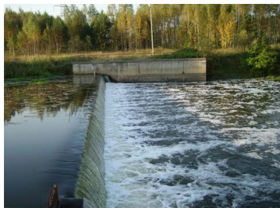
Рис. В.3.4. Прямолинейный в плане водосливной оголовок плотины на р. Наре (водослив с острой стенкой)
