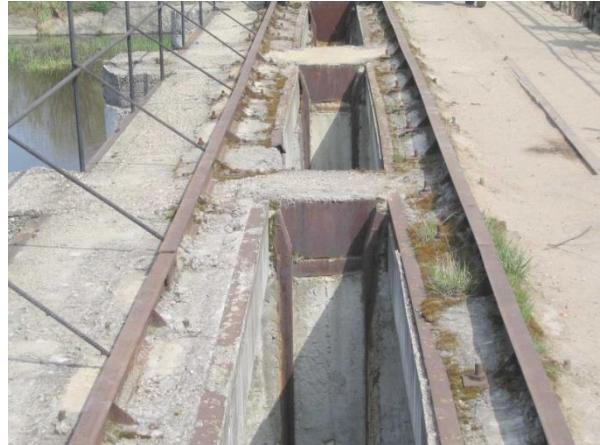
Рис. В. 4.12. Пазы для ремонтных затворов плотины на р. Клязьме
