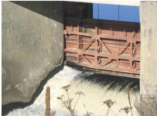
Рис. В.4.7. Плоский затвор плотины Новленского водохранилища на р. Пахре
