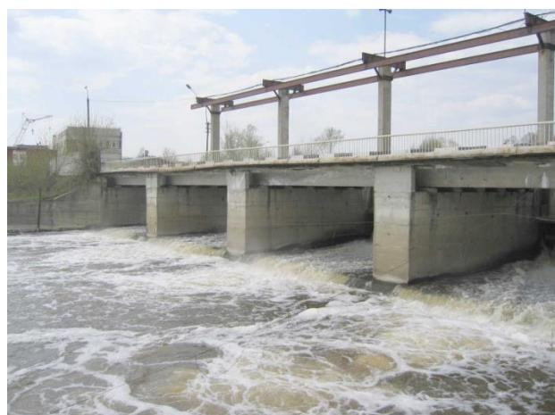
Рис. В.4.2. Монорельсы с кранбалками для маневрирования основными и ремонтными затворами
