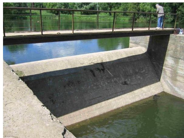
Рис. В.3.2. Прямолинейный в плане водосливной оголовок плотины на р. Осетр
