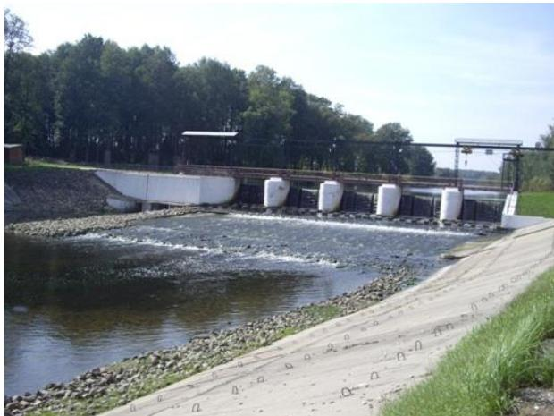
Рис. В.6.3. Водобой, рисберма и отводящее русло плотины на р. Десне
