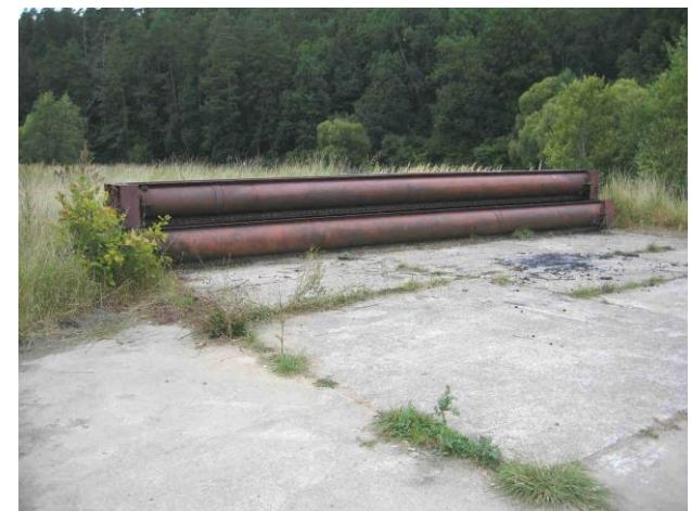
Рис. В.4.10. Металлические шандоры плотины на р. Лопасне
