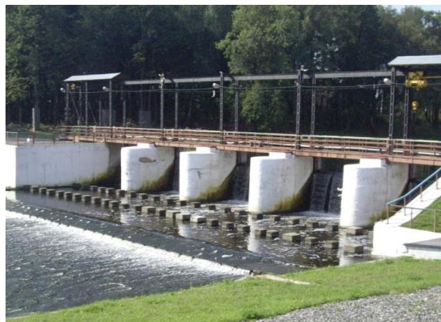
Рис. В.6.4. Гасители на водобое плотины на р. Десне
