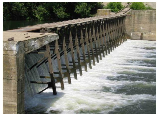
Рис. В.4.8. Плотина с поворотными фермами на р. Осетр
