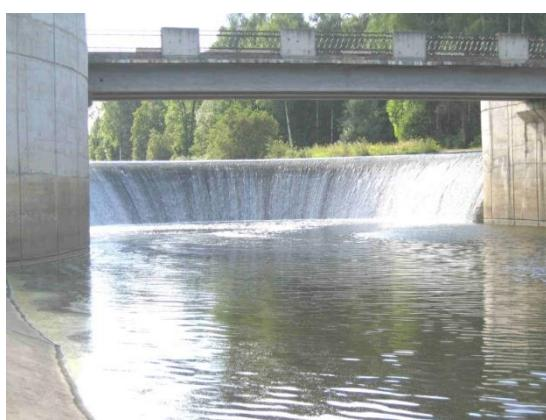
Рис. В.3.3. Криволинейный в плане водосливной оголовок плотины на р. Ламе (вид с нижнего бьефа)
