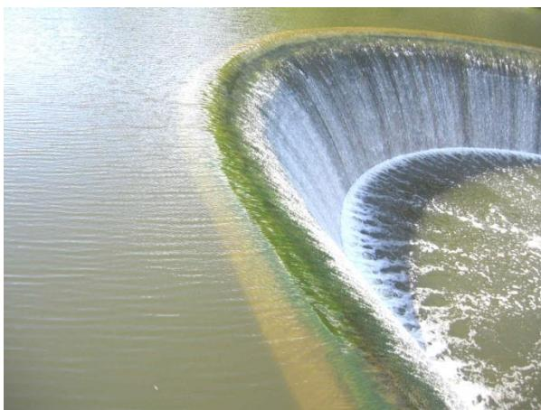
Рис. В.3.1. Криволинейный в плане водосливной оголовок плотины на р. Ламе
