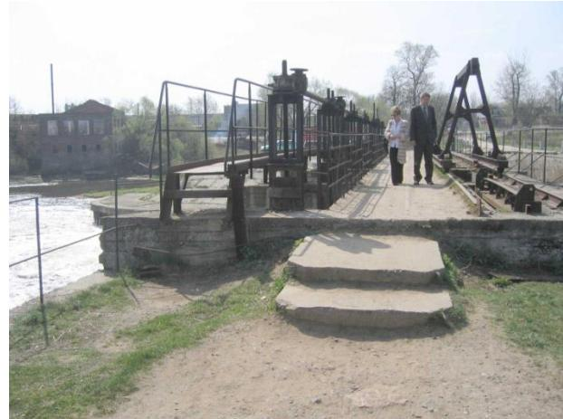
Рис. В.4.6. Линии основных (слева) и ремонтных (справа) затворов плотины на р. Клязьме
