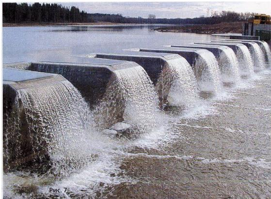
Рис. В.3.5. Лабиринтный водосливной порог плотины на р. Нерль
