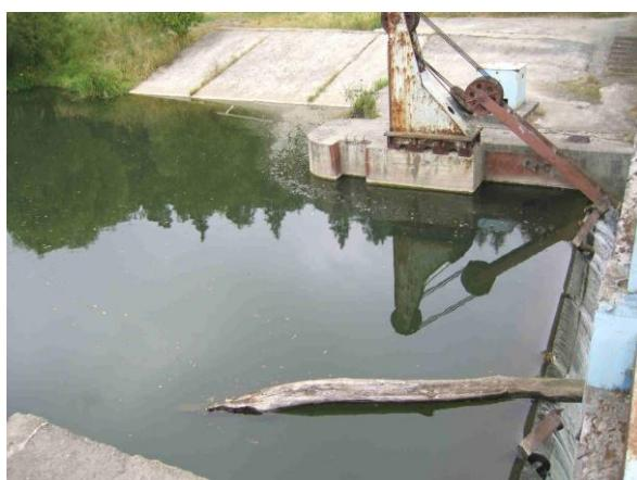
Рис. В.4.3. Электропривод для маневрирования плоским клапанным затвором плотины на р. Лопасне
