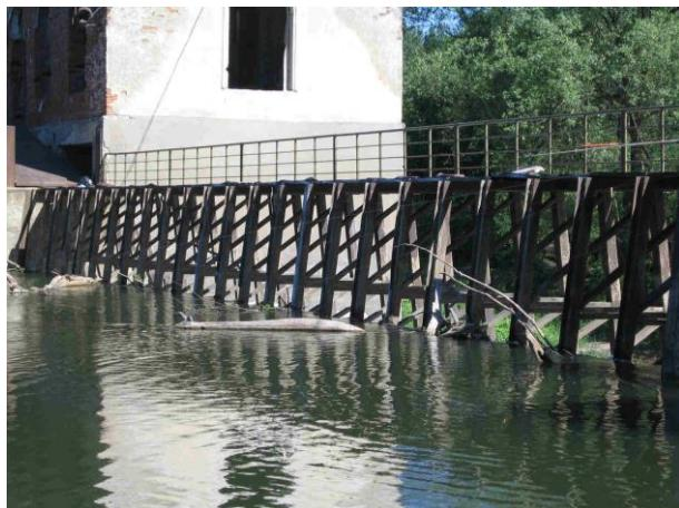
Рис. В.2.5. Водосбросная плотина на р. Осетр
