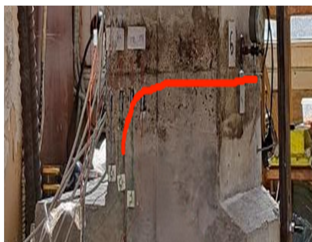
Рис. 11. Экспериментальные исследования опытной модели напорной стены – «трещина по строительному шву-наклонная трещина»
