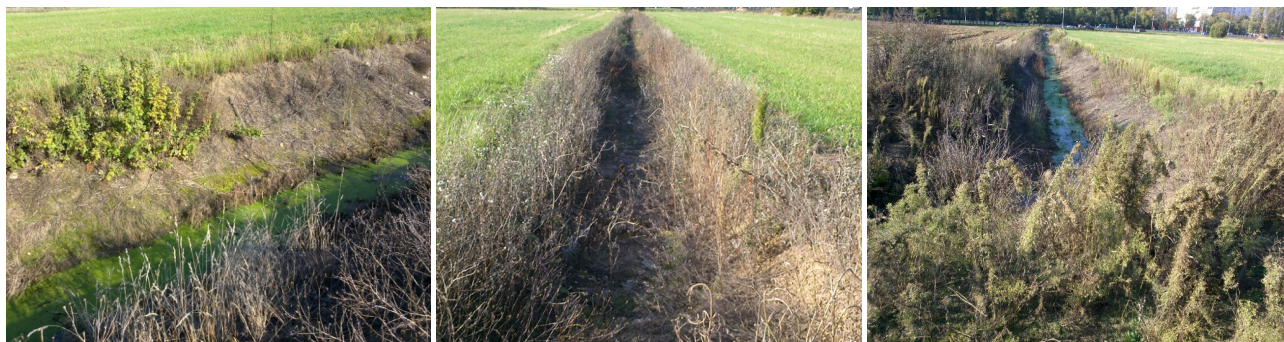
Рис. 2. Состояние каналов мелиоративной осушительной сети до очистки
