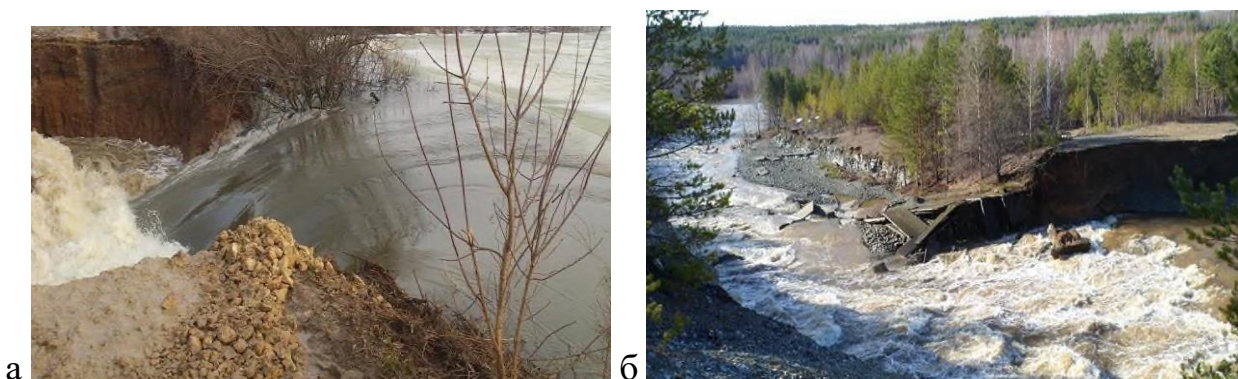
Рис. 1.17. Разрушение подпорных земляных сооружений: а - образование прорана дамбы на р. Мураниха, Московская область; б - последствия разрушения плотины на Колташинском водохранилище, Свердловская область
