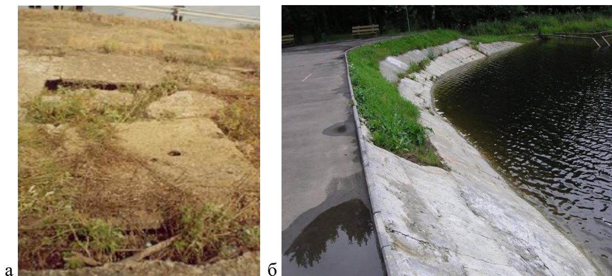
Рис. 3.5. Разрушения и дефекты бетонного крепления верхового откоса
