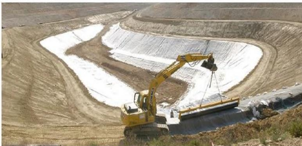
Рис. 4.2. Использование геотекстильной защиты TENCATE при восстановлении ПФУ накопителя промотходов
