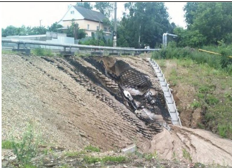
Рис. 3.7. Дефекты в примыкании низового откоса земляной плотины к левому берегу створа гидроузла
