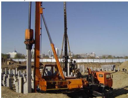
Рис. 17.11. Копровая установка на автомобильном ходу УГМК-12 в процессе забивки свай
