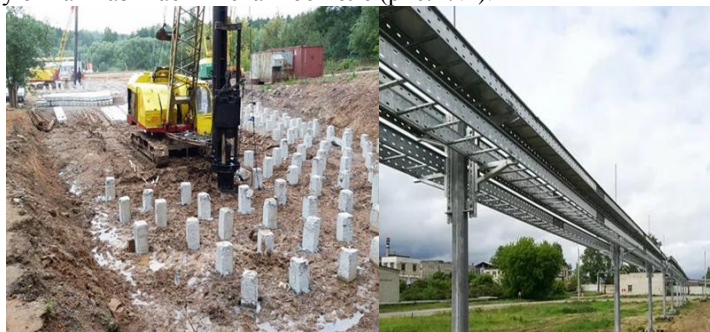
Рис.17.1. Установка свайных опор
