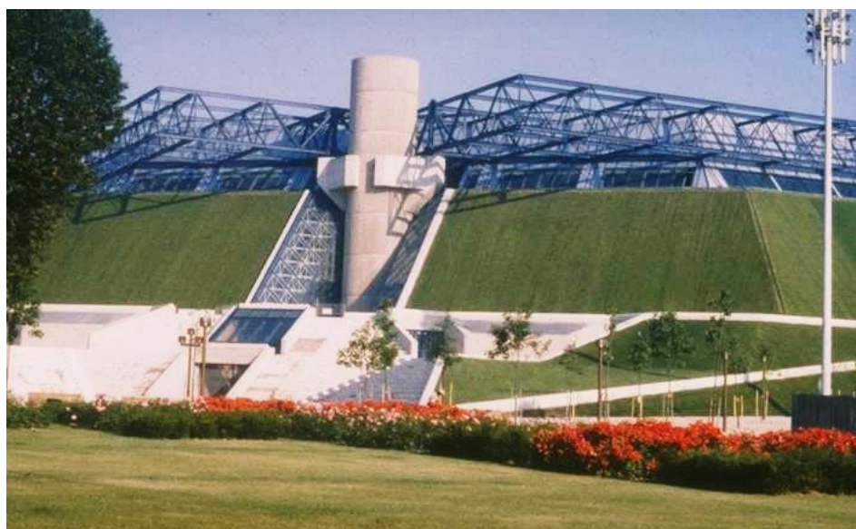
Рисунок 1.15 – Использование геомата для озеленения и водоотведения крыш [100]
