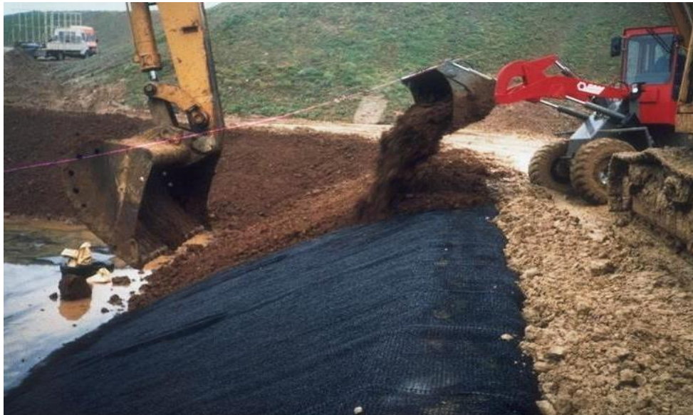
Рисунок 1.16 – Применение геомата для фиксации грунта на берегах водоемов [100]
