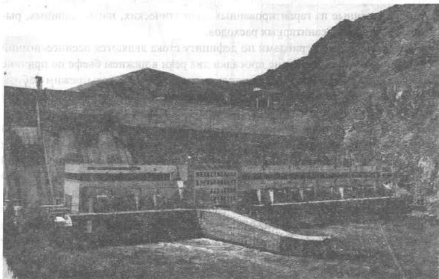
Рис. 5.12. Бухтарминская ГЭС — 1966 год, установленная мощность 675 мвт, среднегодовая выработка — 2,5 млрд кВт·ч, расчётный напор — 67 м; объем водохранилища — 53 км 3 (31 км 3 — полезный объем).
