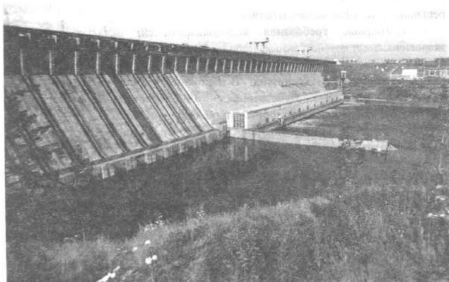
Рис. 5.9. Братская ГЭС – вторая ступень Ангарского каскада (1967 год) с установленной мощностью 4500 мВт и годовой выработкой электроэнергии 22,6 млрд кВт·ч. Расчетный напор 106 метров. Объем водохранилища 169,4 км 3 .
