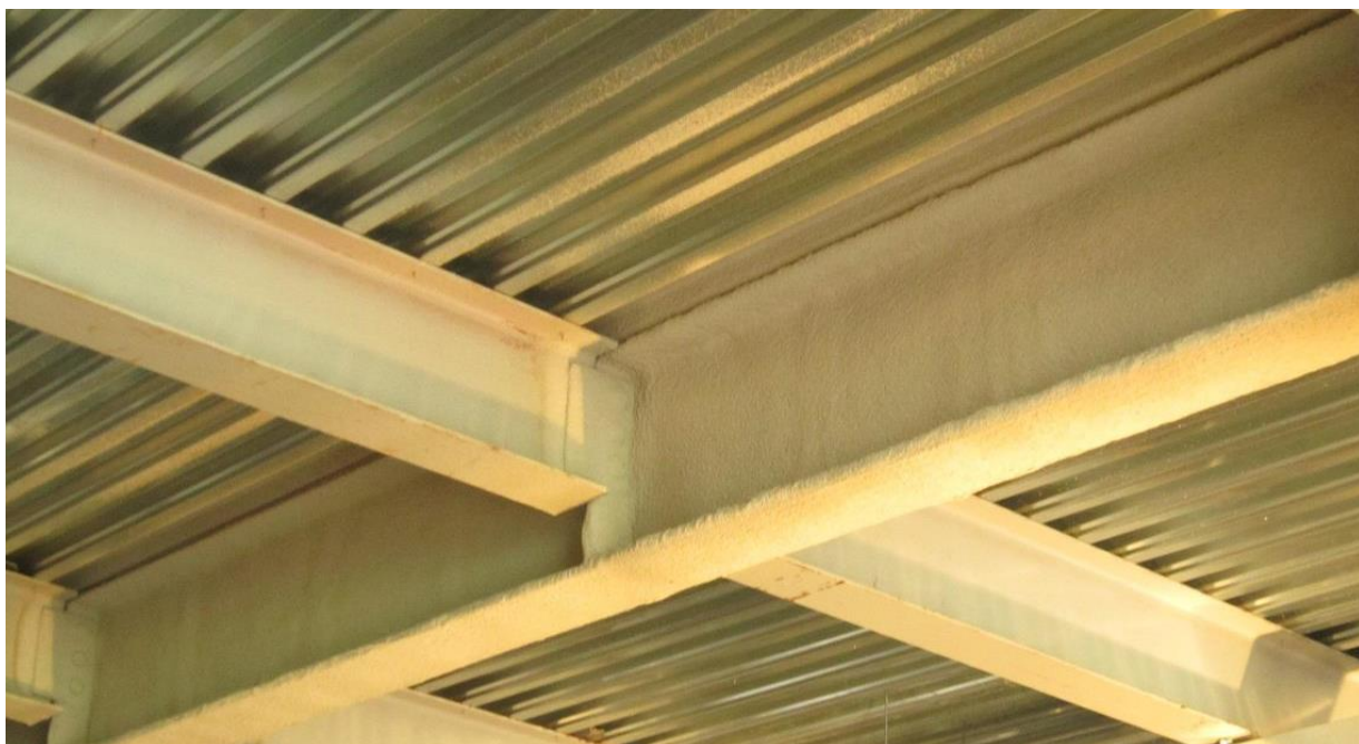
Рис. 2.6 Сопряжение балок в одном уровне [*]
