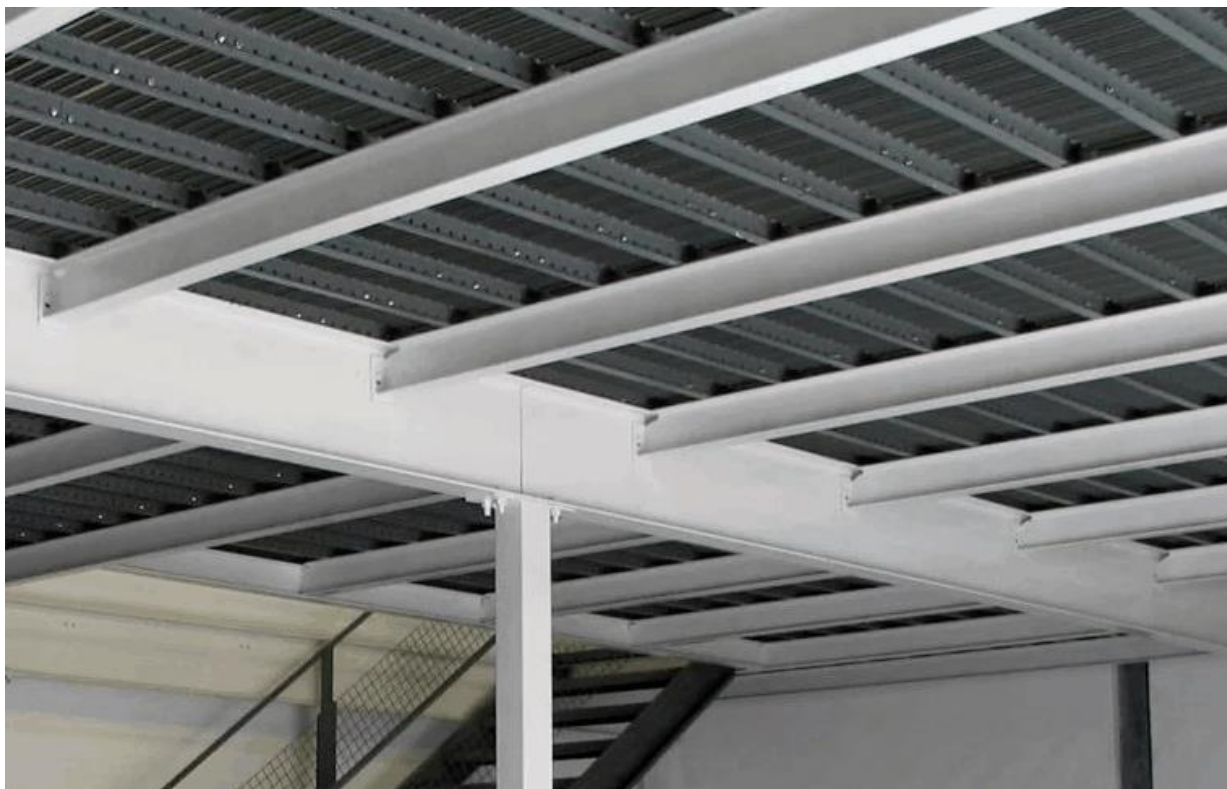
Рис. 2.4 Усложненная балочная клетка [*]
