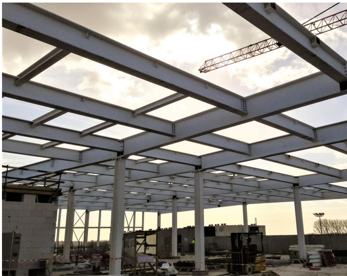
Рис. 2.7 Сопряжение балок в одном уровне [ https://www.technometal.be/ ]
