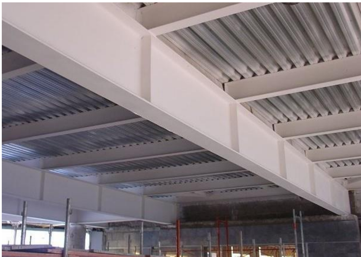
Рис. 2.3 Балочная клетка нормального типа [*]
