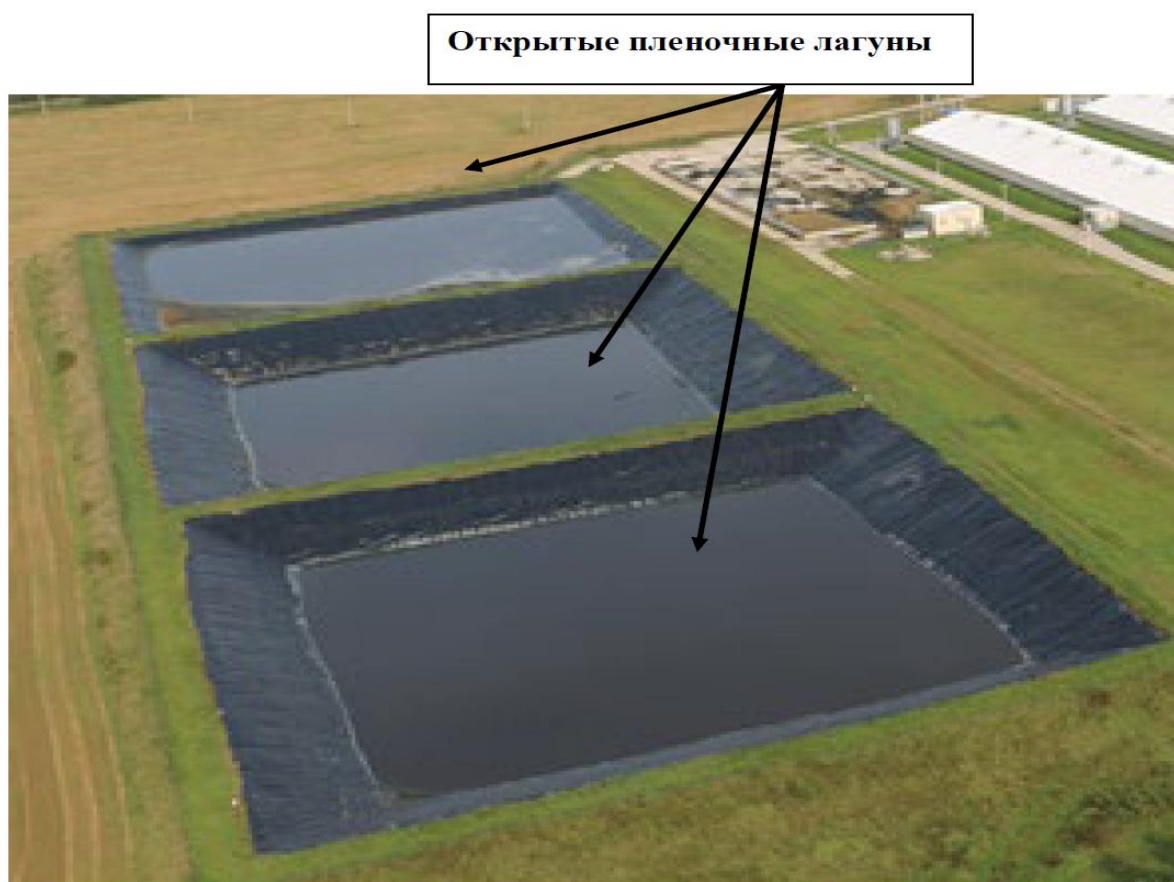
Рисунок 1 – Общий вид лагун с пленочной гидроизоляцией
